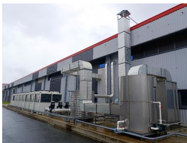
Hình 3.30. Hình ảnh hệ thống xử lý khí thải phát sinh từ công đoạn sơn phủ epoxy/Al-Zn (công đoạn sơn lăn)
