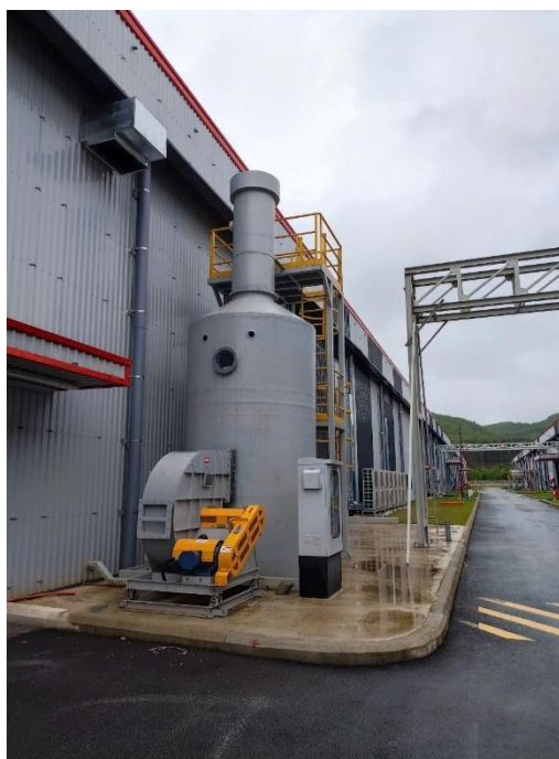
Hình 3.32. Hình ảnh hệ thống xử lý khí thải phát sinh từ công đoạn phun phủ
