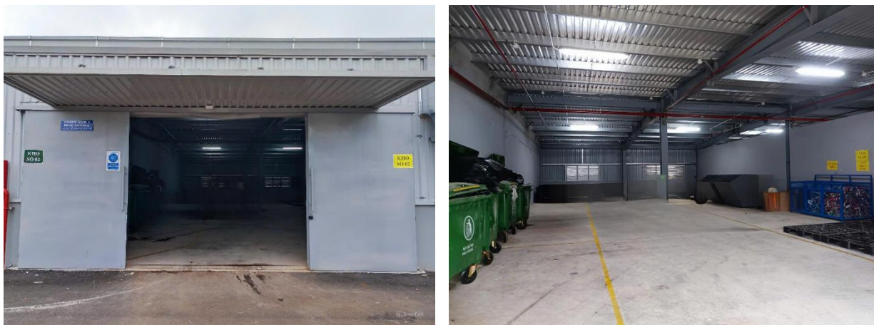
Hình 3.39. Hình ảnh kho chứa chất thải rắn sinh hoạt
