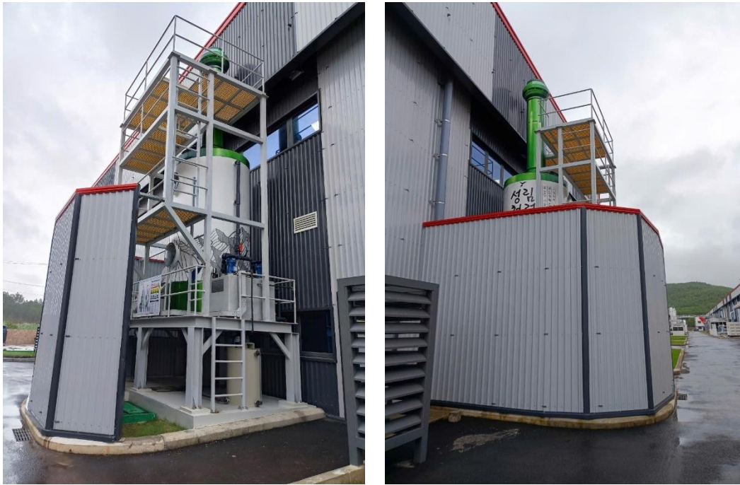
Hình 3.34. Hình ảnh hệ thống xử lý khí thải phả sinh từ phòng QC
