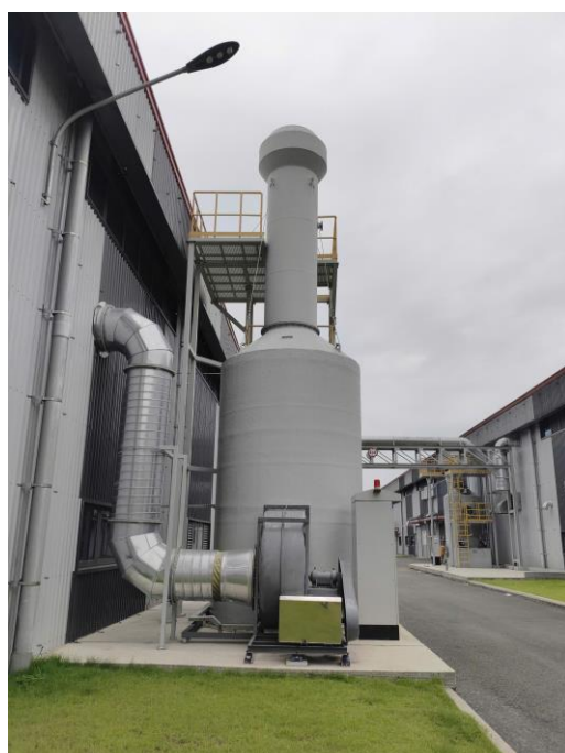
Hình 3.20. Hình ảnh hệ thống xử lý khí thải phát sinh từ công đoạn thiêu kết, khuếch tán và đúc dải (Hệ thống số 2)
