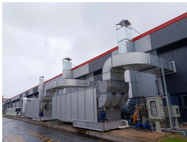
Hình 3.28. Hình ảnh hệ thống xử lý khí thải phát sinh từ công đoạn sơn phủ epoxy/Al-Zn (Hệ thống số 1 và hệ thống số 2)
