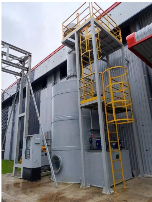
Hình 3.19. Hình ảnh hệ thống xử lý khí thải phát sinh từ công đoạn thiêu kết, khuếch tán và đúc dải (Hệ thống số 1)
