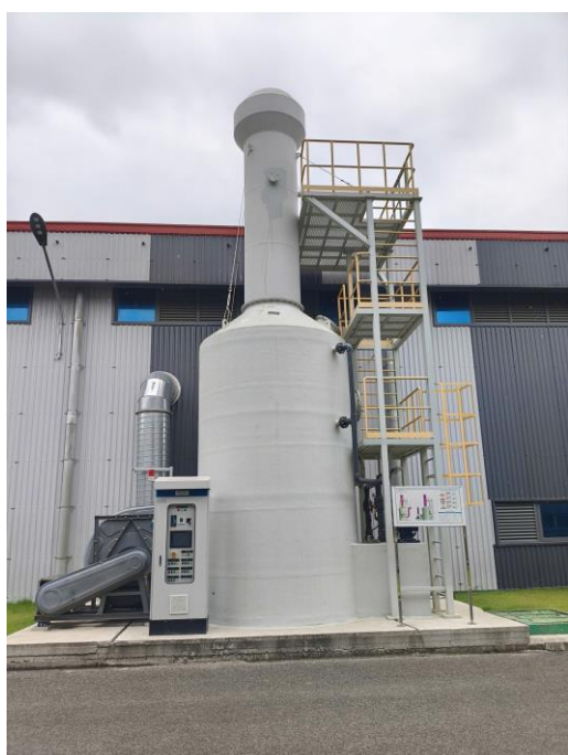
Hình 3.20. Hình ảnh hệ thống xử lý khí thải phát sinh từ công đoạn thiêu kết, khuếch tán và đúc dải (Hệ thống số 2)
