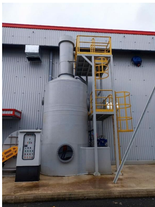
Hình 3.32. Hình ảnh hệ thống xử lý khí thải phát sinh từ công đoạn phun phủ
