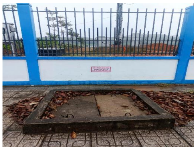
Hình 3.10. Hình ảnh điểm đầu nối nước thải
