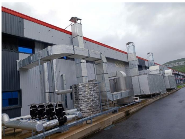
Hình 3.28. Hình ảnh hệ thống xử lý khí thải phát sinh từ công đoạn sơn phủ epoxy/Al-Zn (Hệ thống số 1 và hệ thống số 2)
