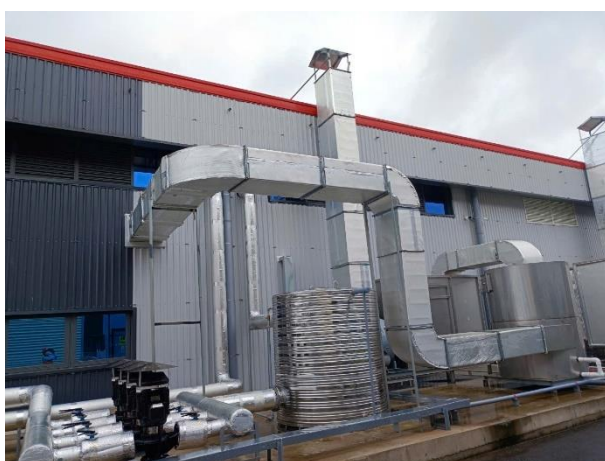
Hình 3.30. Hình ảnh hệ thống xử lý khí thải phát sinh từ công đoạn sơn phủ epoxy/Al-Zn (công đoạn sơn lăn)
