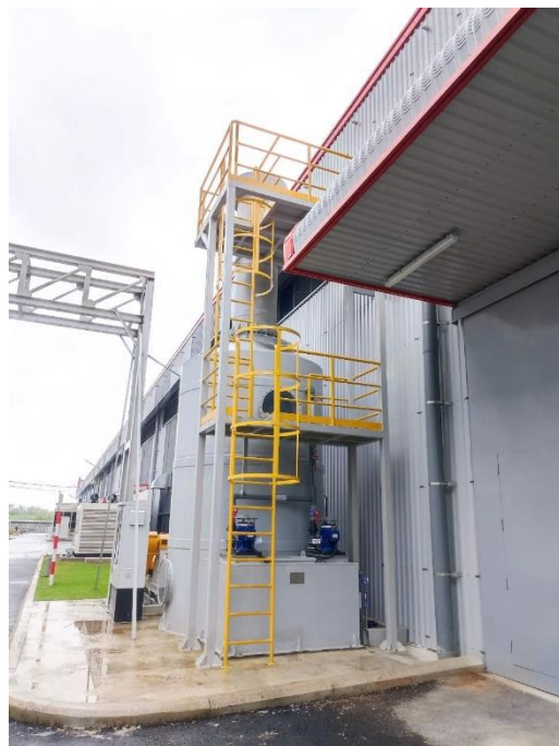
Hình 3.19. Hình ảnh hệ thống xử lý khí thải phát sinh từ công đoạn thiêu kết, khuếch tán và đúc dải (Hệ thống số 1)
