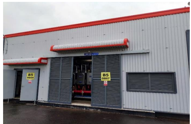
Nhà nồi hơi
