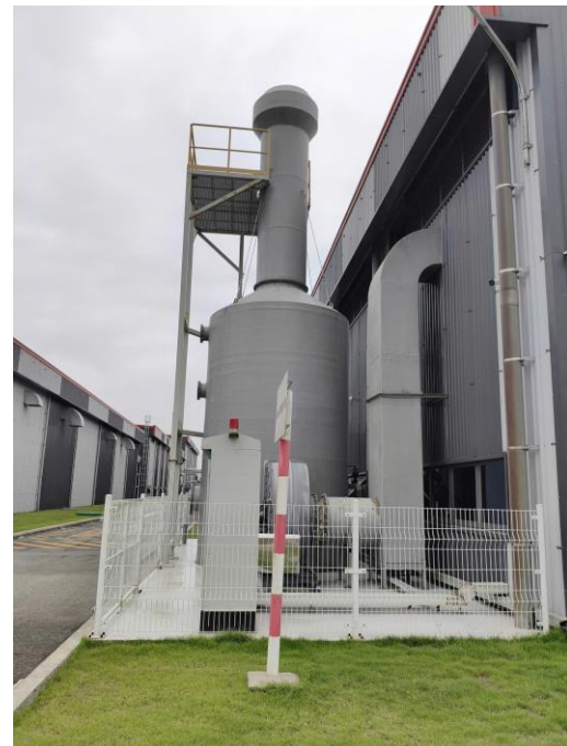
Hình 3.36. Hình ảnh hệ thống xử lý khí thải phát sinh từ công đoạn xả keo
