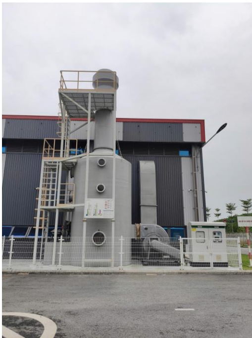
Hình 3.36. Hình ảnh hệ thống xử lý khí thải phát sinh từ công đoạn xả keo
