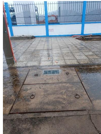
Hố ga đầu nối nước mưa
