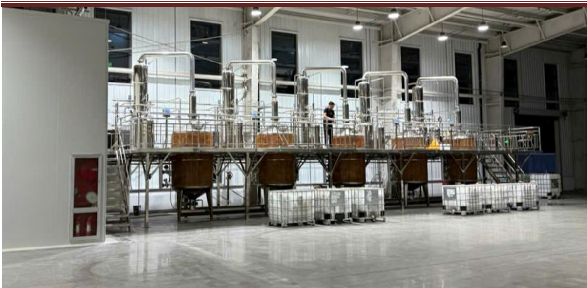
Hình 1.7. Một số hình ảnh máy móc thiết bị lắp đặt tại dự án
