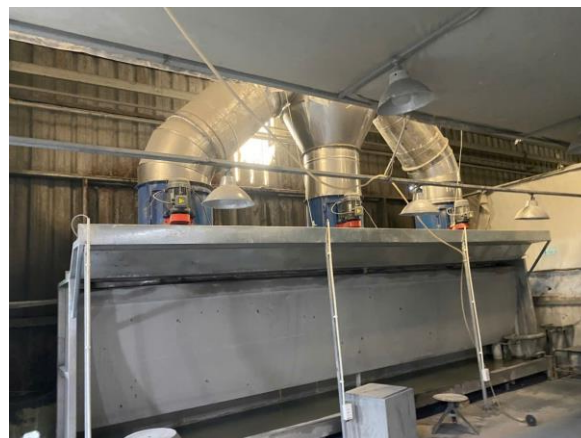
Hình 3.11. Hệ thống xử lý bụi khu vực mài hoàn tất sản phẩm
